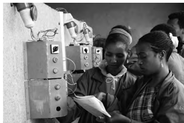
給水関連の電気機械整備訓練の様子
