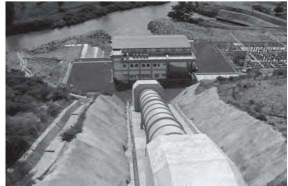
発電所・水圧管路・スイッチヤード
