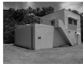
送水ポンプ場
