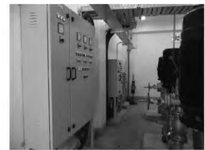
送水ポンプ施設
